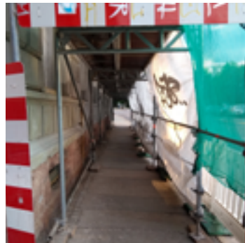
Baustelle No. 458 (Chemnitz)
